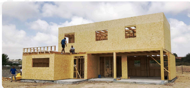
CERRAMIENTO EXTERIOR CON OSB3
