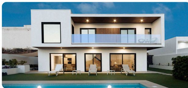
VIVIENDA TERMINADA · VISTA EXTERIOR
