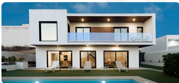
CUBIERTA PLANA TRANSITABLE
