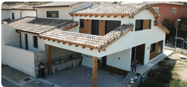
CUBIERTA INCLINADA · TEJA MIXTA CERÁMICA
